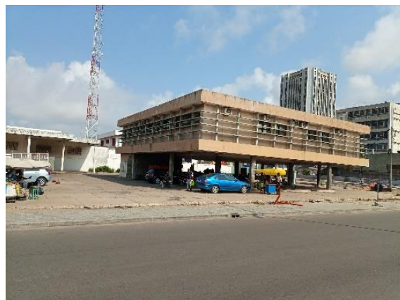
Bâtiment de la station SONACOP au Nord-Est du site
