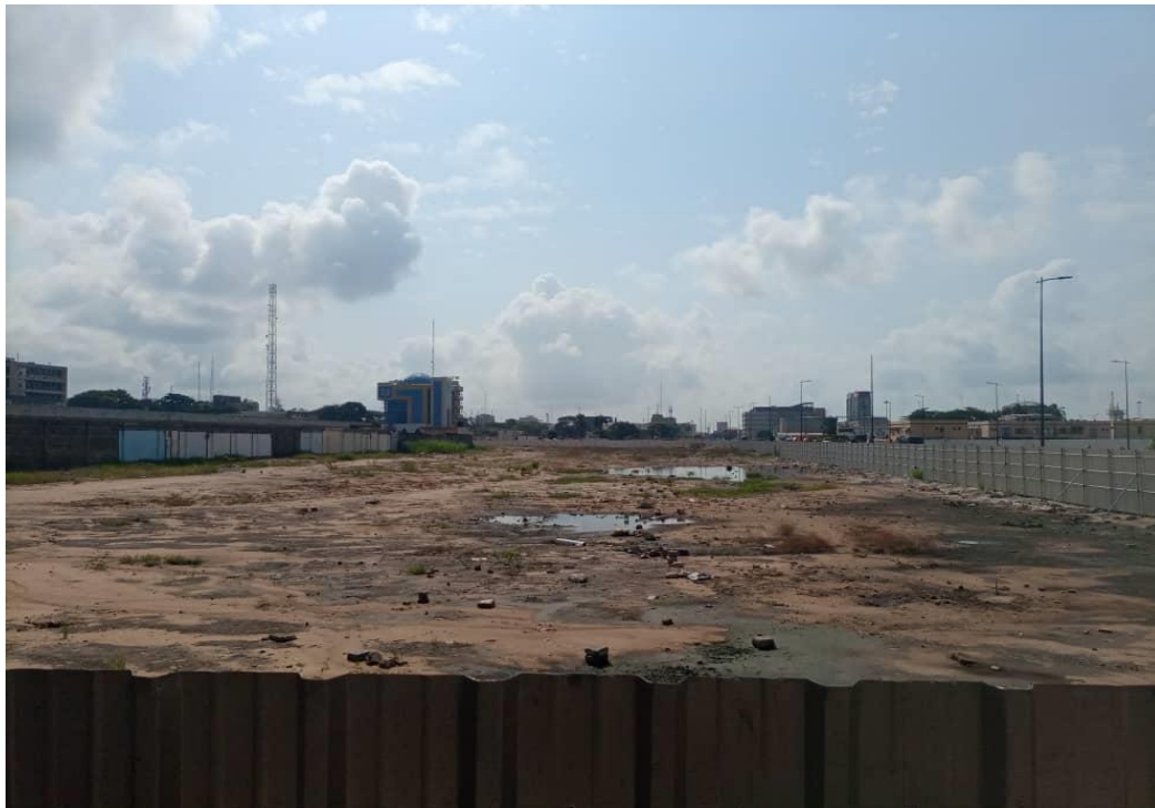
Photo 5 : Aperçu de l'intérieur de l'état actuel du site du projet Prise de vue : DIGITAL GROUP SARL, juillet 2021
