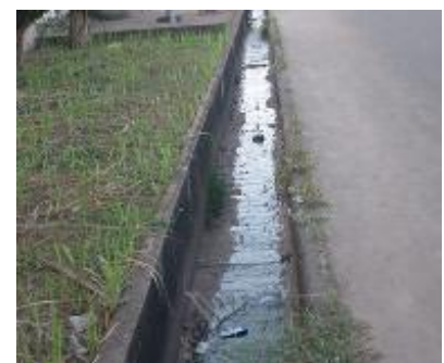
Aperçu d'un caniveau le long de la voie Photo : TERRABO, novembre 2014
