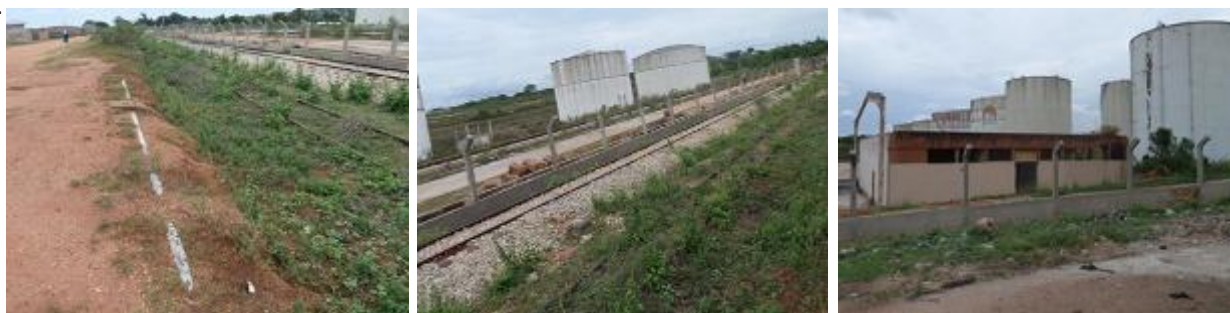
Aperçu des installations de GESTOCI Bouaké Photos : TERRABO, novembre 2014
