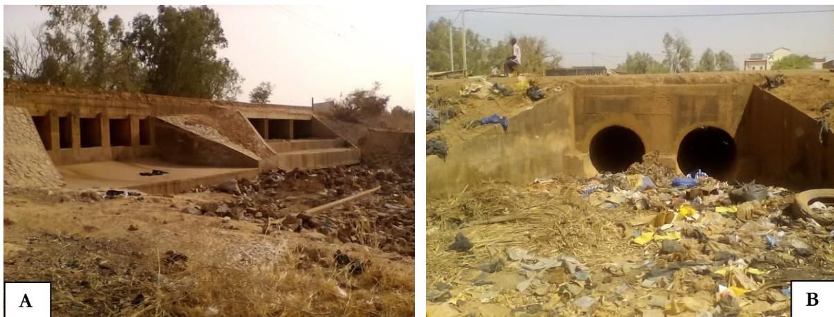
**Photo 6:** Vues partielles d'ouvrages de franchissement (dalots) (A) et (B) sur le tronçon de la route du projet,
