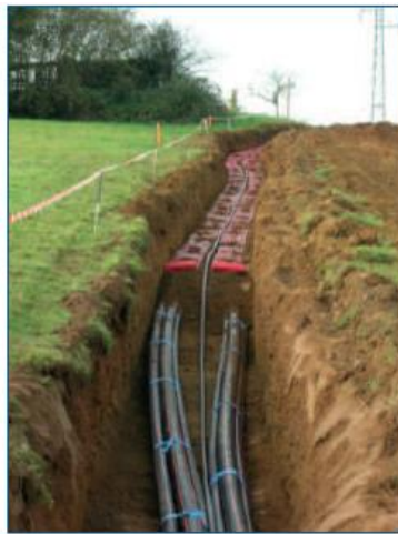
Figure 12 : Exemple de pose en fourreaux
