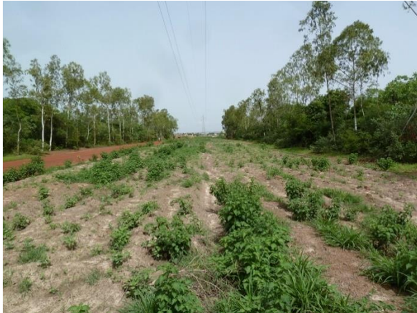
Layon de la ligne à 150 kV Sirakoro – Ségou qui sera intégré dans le nouveau poste. (©X. MONBAILLU)
