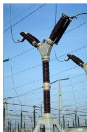
Figure 1. Disjoncteur (©RTE)
