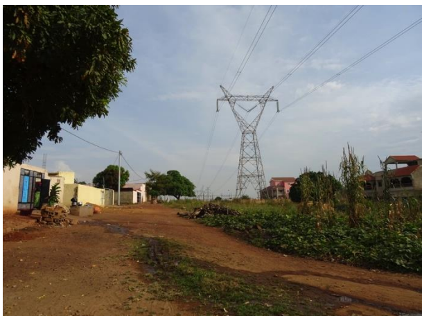
La ligne THT Manantali – Kodialani à 700 m au Nord du poste de Kodialani visible au fond de la photo. (@X. MONBAILLU)
