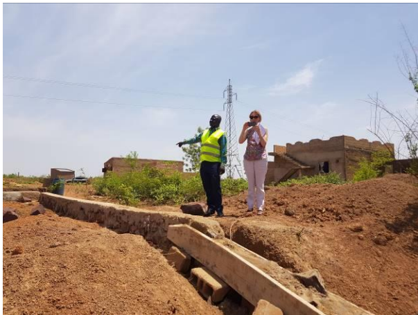
Soubassement sur le site du poste de Dialakorobougou. (©X. MONBAILLU)
