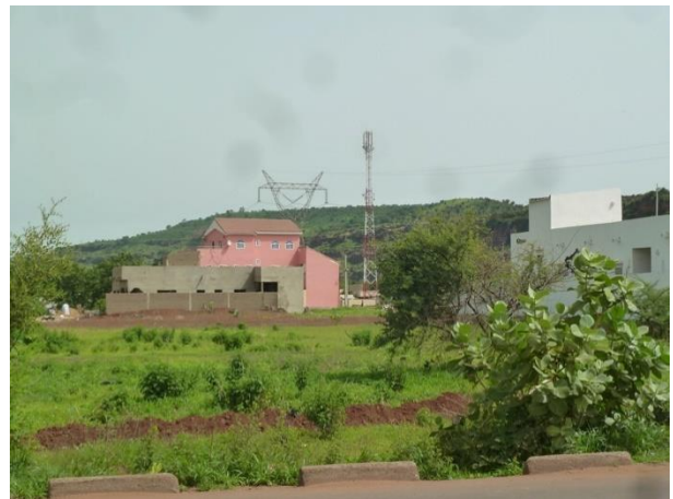
Ligne à 225 kV Kodialani – Manantali passant entre deux maisons au Nord du poste de Kodialani. (@X. MONBAILLU)
