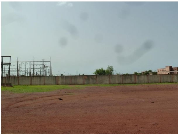
Façade nord du poste de Kodialani avec l’emplacement des nouvelles travées à installer à droite sur la photo. (@X. MONBAILLU)
