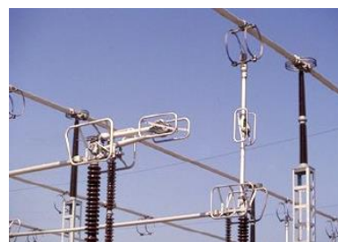
Figure 2. Sectionneur (©RTE)
