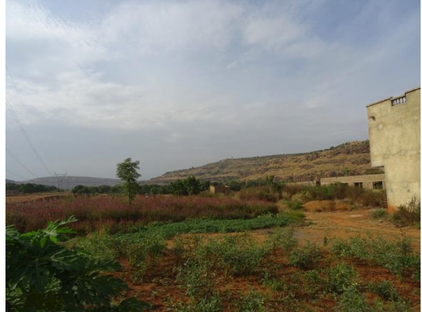
Vallée de la rivière Kodialani à l’emplacement du pylône aérosouterrain. A gauche la ligne THT Manantali – Kodialani. (@X. MONBAILLU)
