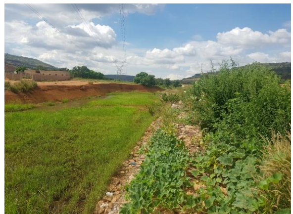
Vue sur pylône côté Kati (Octobre 2019)
