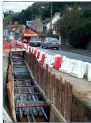
Figure 13 : Exemple de chantier de pose de liaison souterraine
