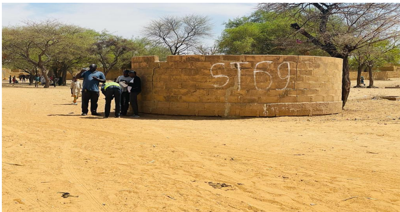
Photo 2 : Vue d'un forage impacté à Balbada
