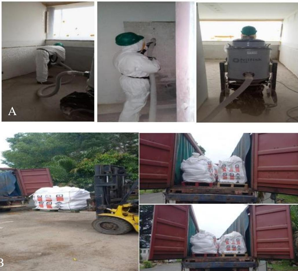
Figure 25 : Images du désamiantage et transfert des déchets amiantés à Thomasset
