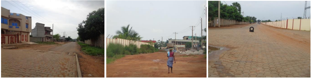
Planche 5 : Etat des voies d'accès au site d'accueil du projet
