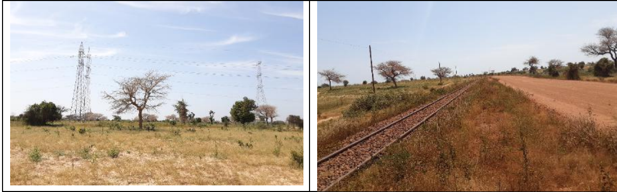
Photo 40 : réseaux de concessionnaire traversés par les tronçons de Thiès (mission 16 octobre 2021, HPR-ANKH)
