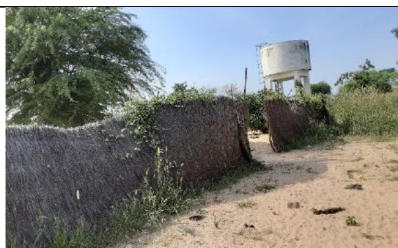
Château d'eau à Maka Fall
