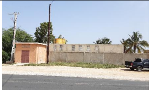
Château d'eau dans la bretelle 671-670
