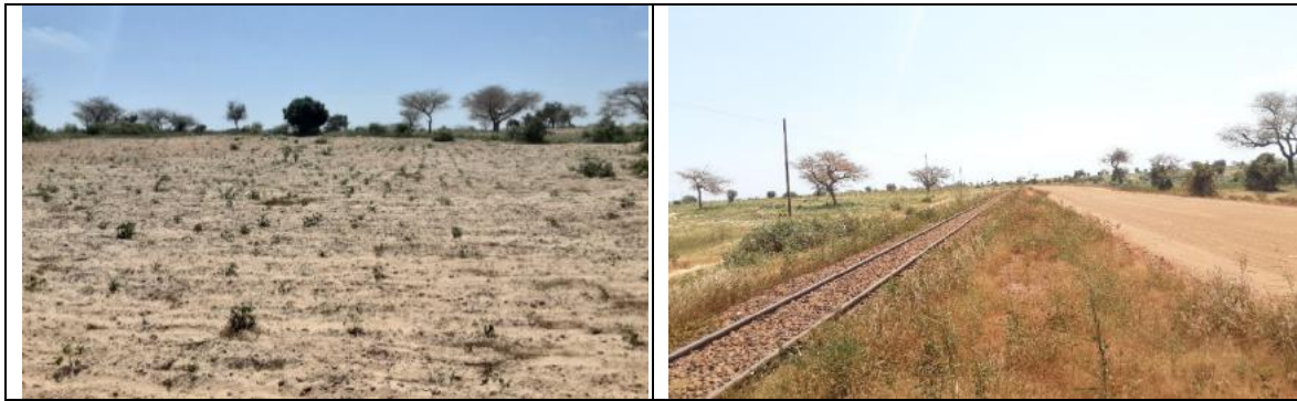
Photo 26 : vue segment 1 du tronçon 1 (Source photos : mission 13 octobre 2021, HPR-ANKH)
