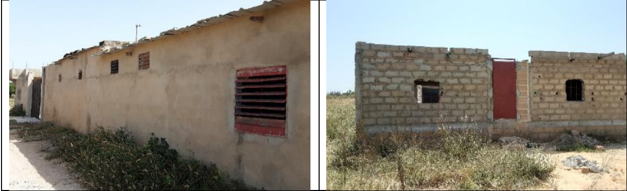
Photo 43 : BATIS dans l'emprise du tronçon ((photo mission 19 octobre 2021, HPR-ANKH)
