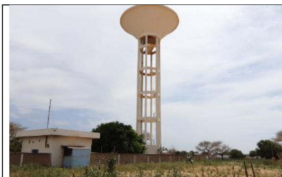
Forage et château d'eau à Plene dedd
