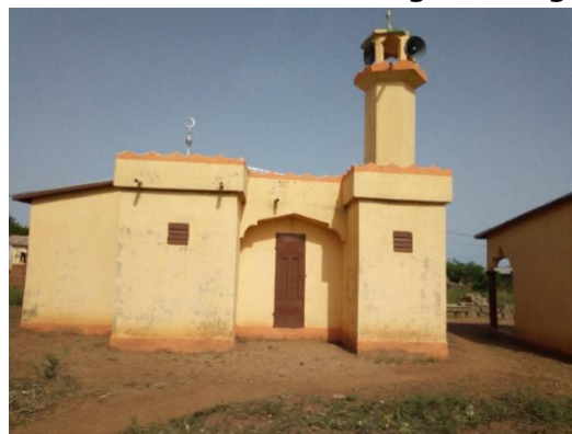
Figure 27: Mosquée à Blitta Losso
