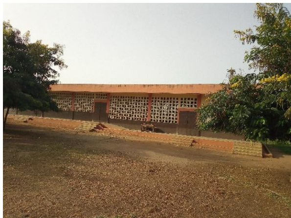
Figure 22: Ecole primaire Publique Centrale C à Blitta Losso
