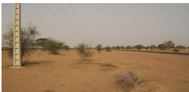
Photo 2 : Présence de ligne de haute tension
