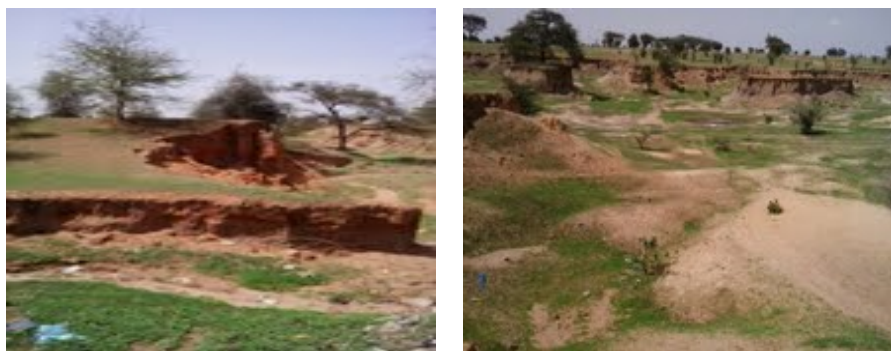
Photo 7 : Excavations représentant zones d'emprunts (Tronçon Linguère – Dahra)
