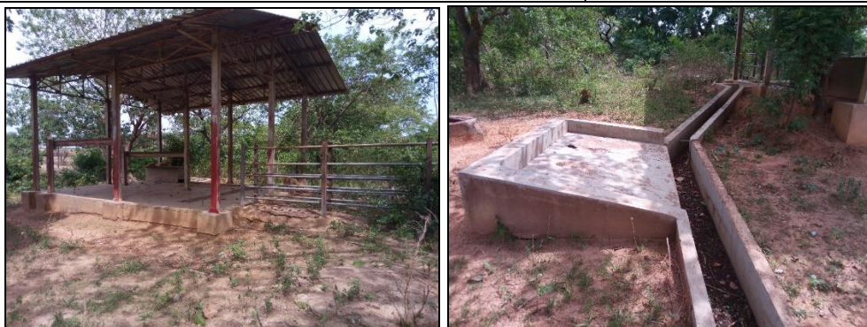
Photo 7 : Vue de l'abattoir et du réseau d'évacuation des eaux usées de l'abattoir du marché à bétails de Tienko.
