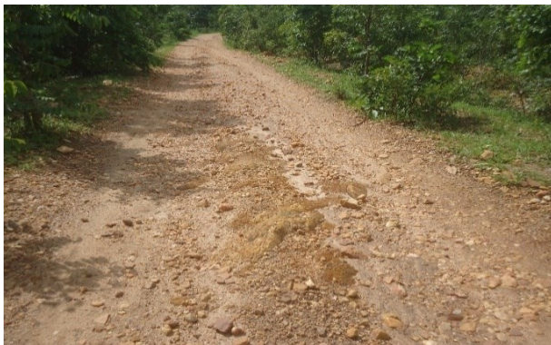
Photos 10 : PK 2+000 – sol de plateforme constitué de gravier roulé
