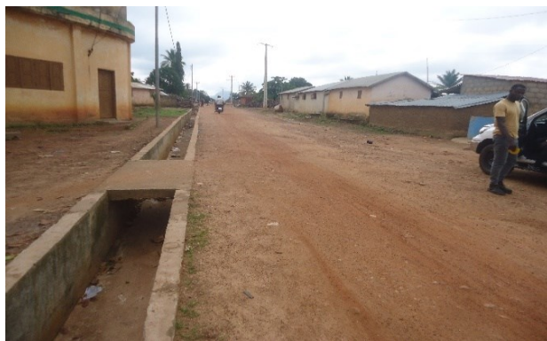
Photos 6 : PK 0+000 – aperçu d'un caniveau existant
