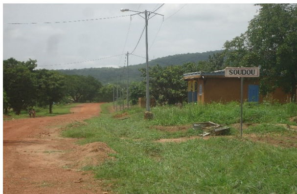
Photos 16 : PK 9+450 – entrée du village de Soudou
