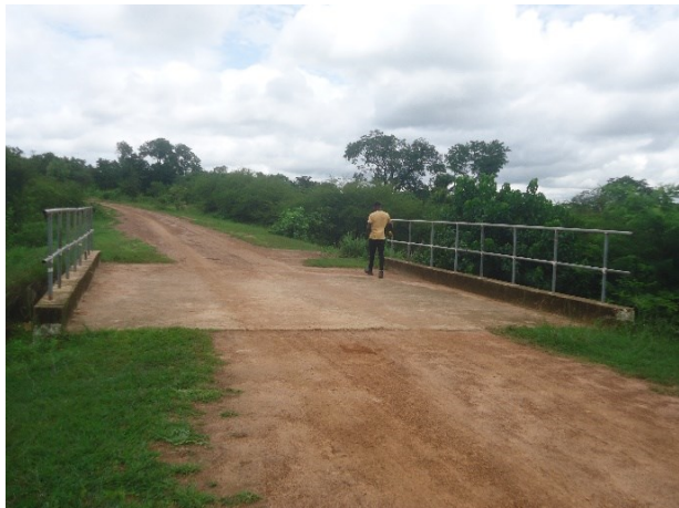
Photos 25 : PK 7+760 – dalot 2x4,00x3,00 en bon état à conserver
