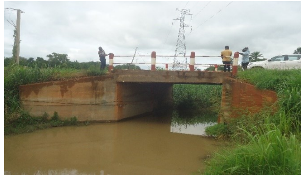
Photos 23 : PK 1+090 – dalot 1x4,00x2,50 en bon état à conserver
