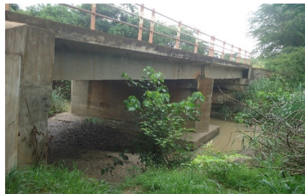
Photos 7 : PK 11+320 – pont à poutres à 2 travées de 9 m sur la rivière Kpaza à conserver
