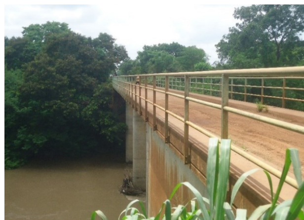
Photos 28 : PK 27+050 - Pont à poutres à 4 travées de 15 m sur la rivière Mono avec 3,60 m de largeur roulable en bon état à conserver et dédoubler
