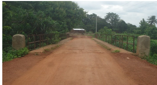
Photos 19 : PK 17+040 – pont à poutres à 3 travées de 10 m sur la rivière Sèyo à conserver et dédoublement
