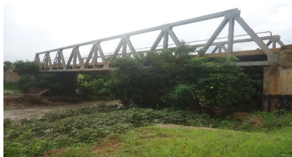
Photos 20 : PK 22+350 – pont métallique à une travée de 40 m sur la rivière Kpam à conserver
