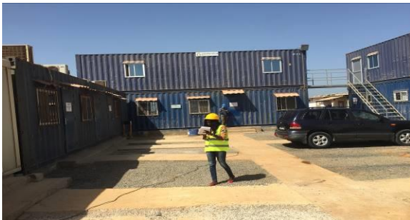
Bureaux du chantier
