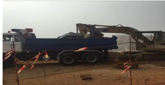
Évacuation des déblais
