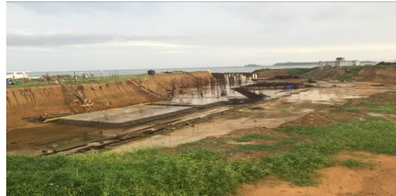
Travaux de fouilles en cours
