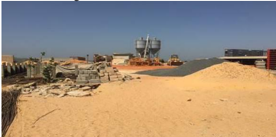
Centrale à béton et stockage de matériaux
