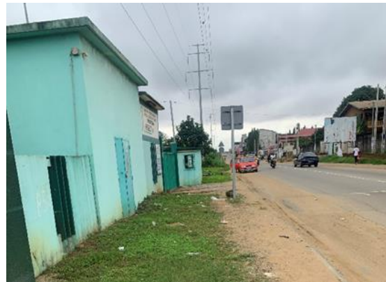
Photo 3-2 : point d'achèvement de la canalisation
