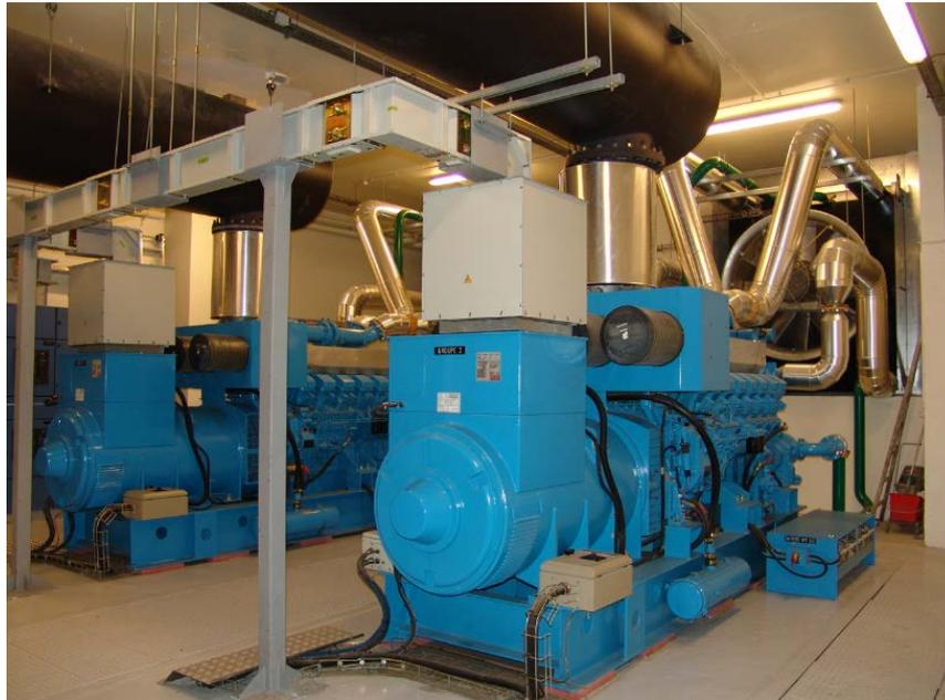
**Photo 9 : Ensemble groupe électrogène**
