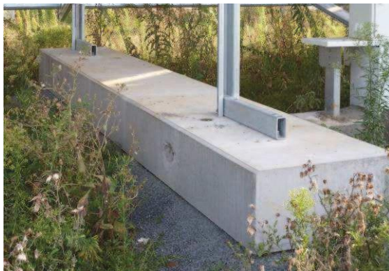
Photo 8 : Types de fondation - pieux battus (gauche) et semelle béton (droite)
