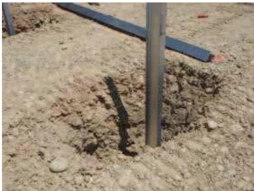
Photo 8 : Types de fondation - pieux battus (gauche) et semelle béton (droite)
