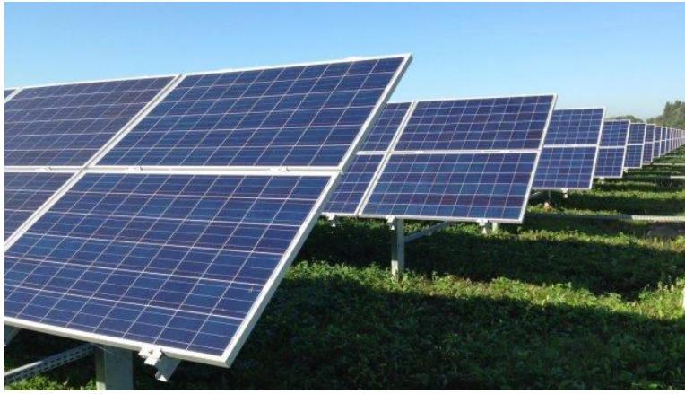
Figure 6: Aperçu d'un champ photovoltaïque
