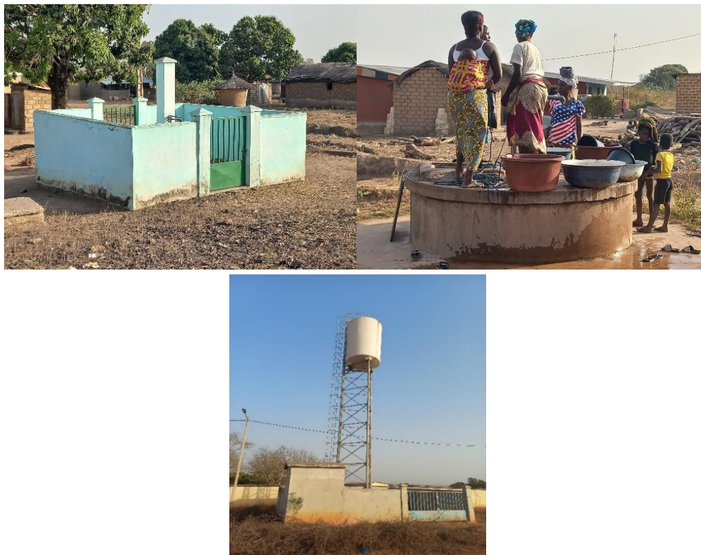
Figure 28 : Sources d'eau potable de Sokoro 1
