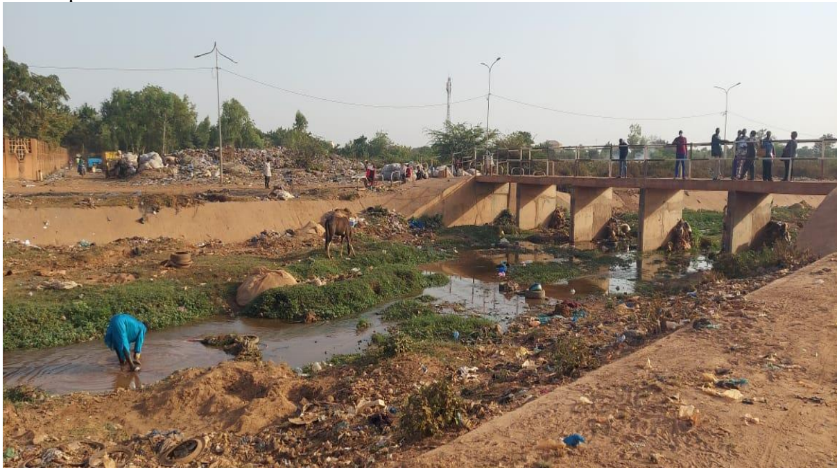
Photo 10 : Zone du bassin de rétention
