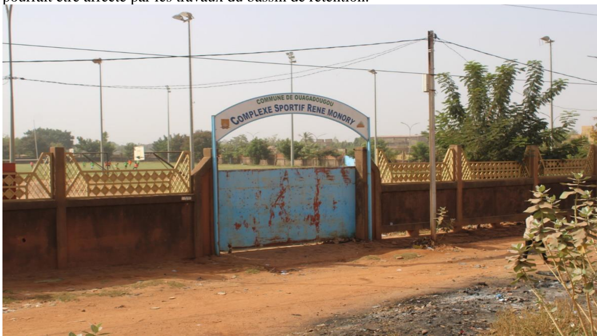
Photo 9: Vue du stade René Monory situé dans l'emprise du bassin de rétention
