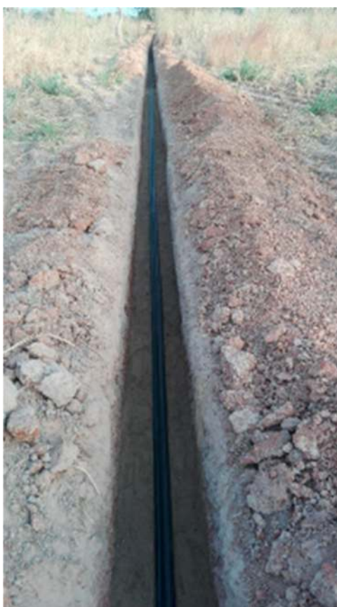
Photo 3: pose de tube PEHD au fond d'une tranchée
