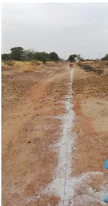
Photo 1: vue d'un marquage de tranchée au moyen de cendre
