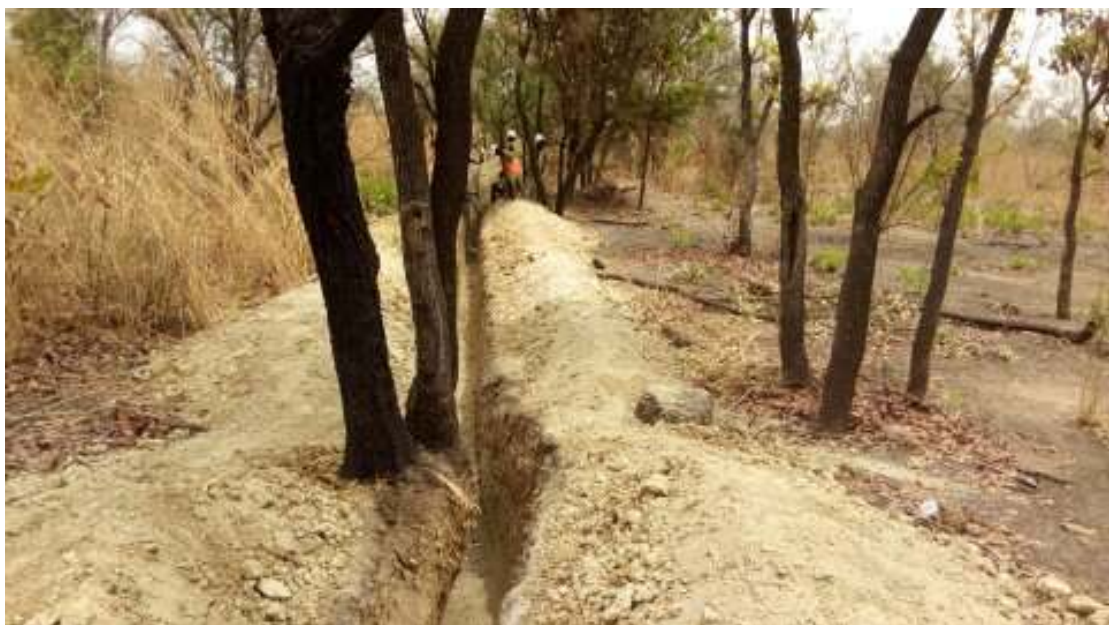
Photo 11 : tranchée de fibre optique jouxtant des pieds de tamarinier, axe Ouaga - Pô
