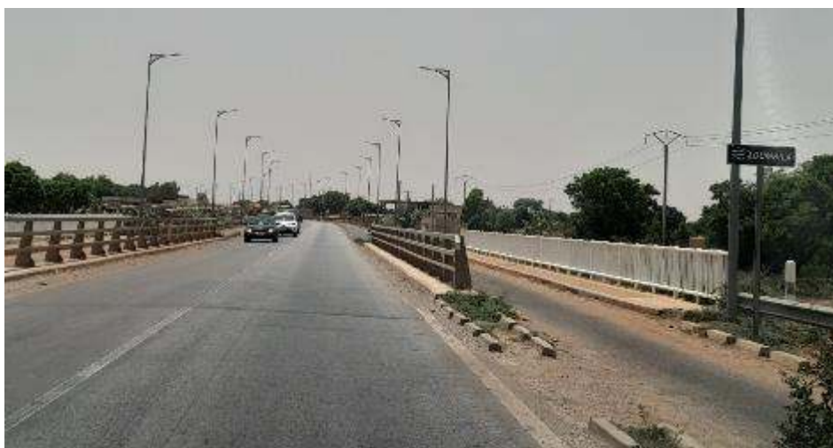
Photo 8 : vue du pont au niveau du barrage de Loumbila
