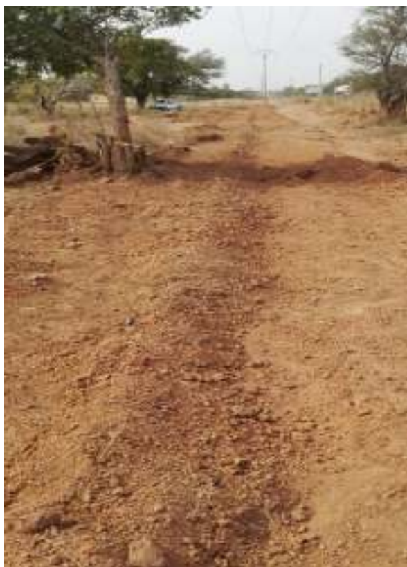
Photo 4: vue d'un remblayage fini par suite de méthode HIMO
